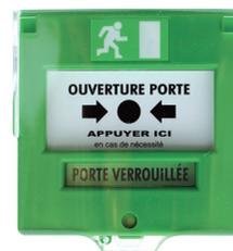
CONTRÔLE DU BOÎTIER D'OUVERTURE D'URGENCE (VERT) : la fenêtre du boîtier doit toujours être de couleur VERTE
